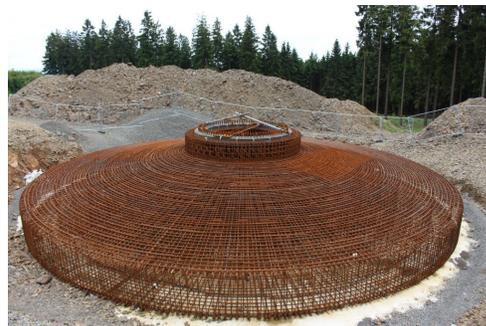
Damit das Windkraftwerk auch sicher steht, ist ein entsprechendes **Fundament** erforderlich. Dies hat einen Durchmesser von 20 – 30 Meter und eine Tiefe bis zu 4 Meter. Hier werden 1.300 Kubikmeter Beton und 180 Tonnen Stahl verbaut. Insgesamt hat das **Fundament** ein Gewicht von 3.500 Tonnen.
